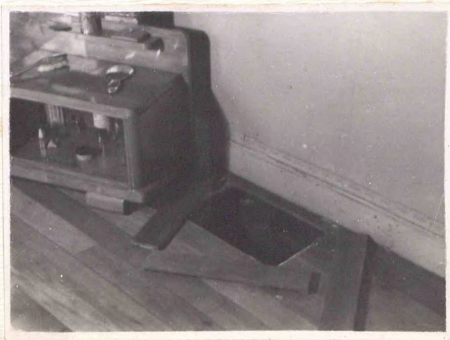
Sacadas las tablas que cubrían la entrada al entrepiso.-
