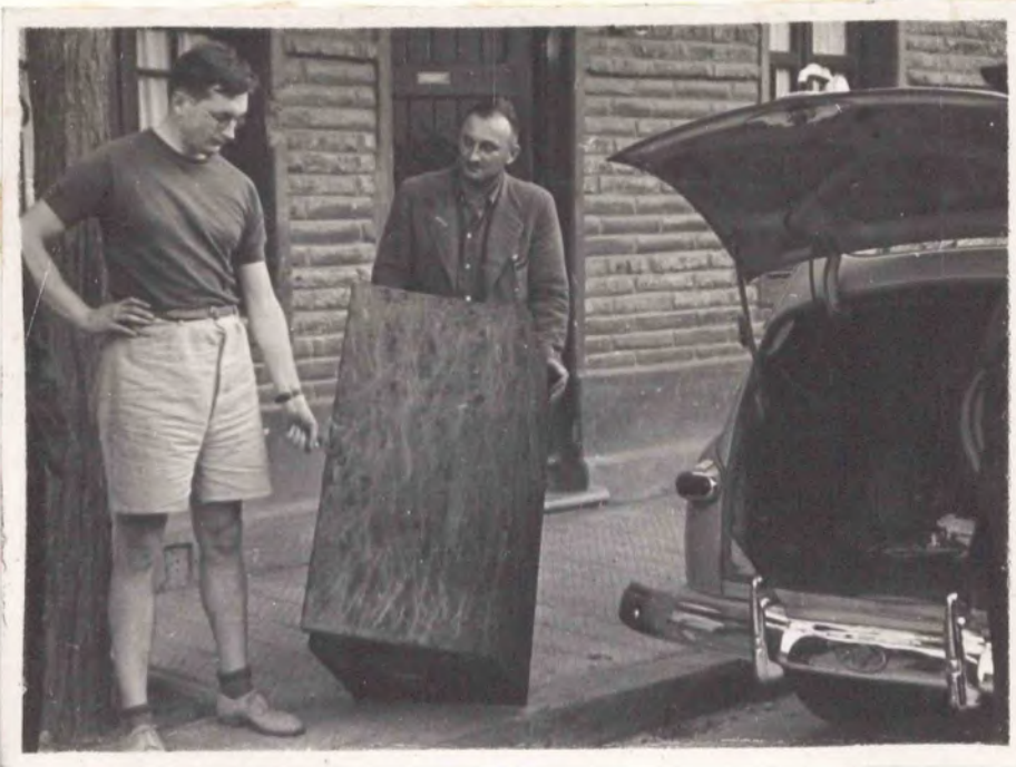
Kröll y Graner, sacan de la casa del primero la caja que contenía el aparato de radio.-
