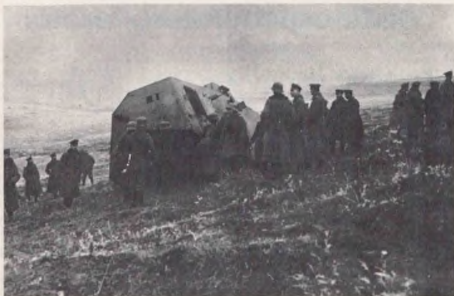
Bild 4: Ein Kampfwagen ist an einer Böschung hängengeblieben.
