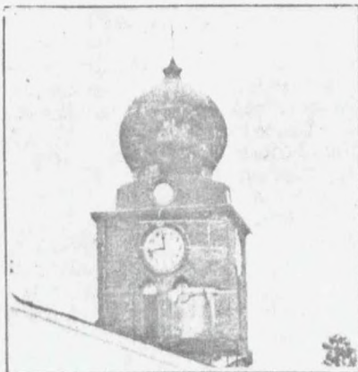
Centenario reloj de la Iglesia de San Fernando, que será reparado próximamente.
